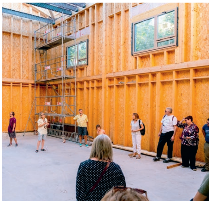
D'ici cet hiver, ce tout nouveau bâtiment, accolé à l'arrière du bâtiment historique, sera entièrement terminé et prêt à accueillir les premières compagnies en quête de création.
