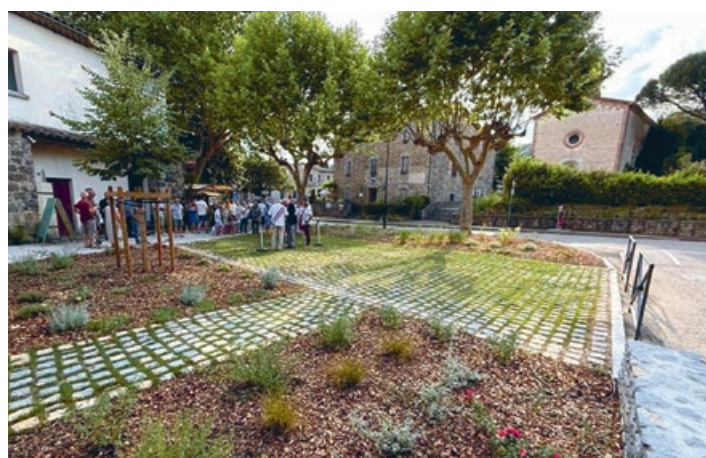
La désimperméabilisation des sols est une démarche que l’Agglo encourage dans les projets d’aménagement de ses communes, comme ici sur la place du Tilleul à Gènerargues.
