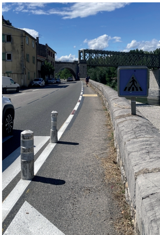
Aménagements de sécurisation des piétons à Anduze le long de la D907.
