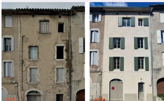
Ravalement de façades à Anduze.
