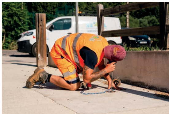
Un agent de la REAAL recherche de fuites d'eau par écoute des sols.
