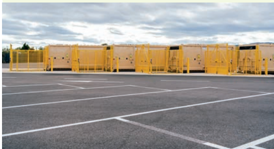
Le centre multi-flux dispose de pas moins de 17 quais de déchargement.
