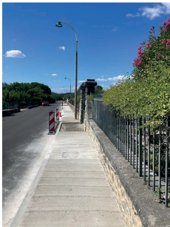
Un trottoir pour sécuriser les déplacements le long de la route départementale.
