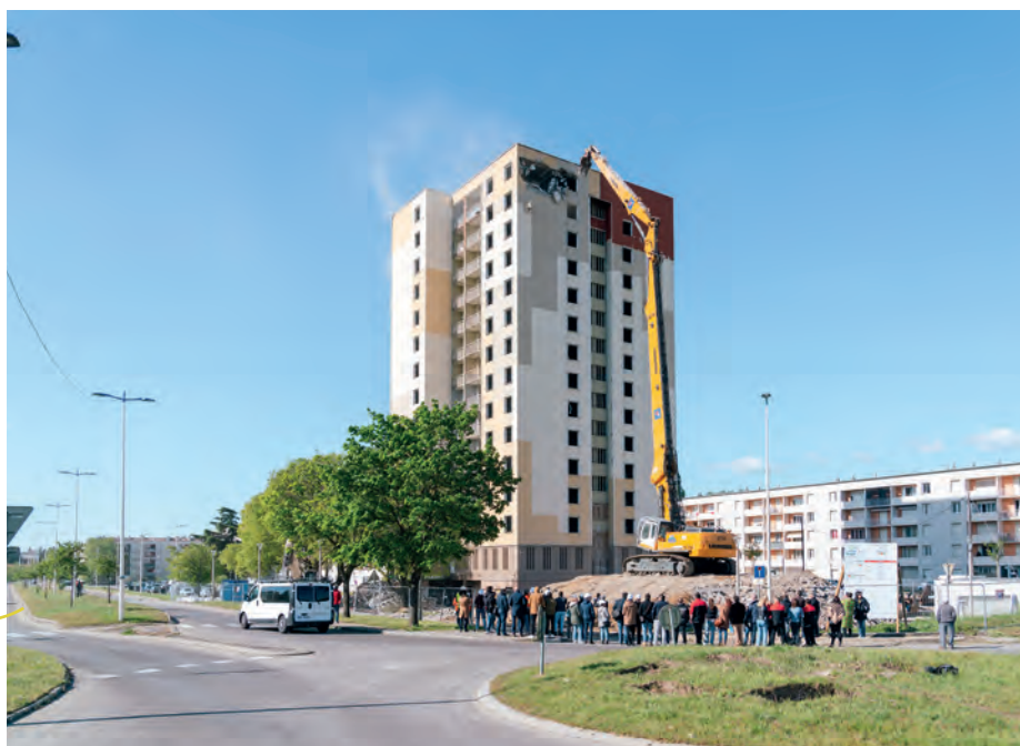
L'immeuble de 15 étages, inhabité depuis 2020, était le dernier ouvrage concerné par le programme ANRU 1 dans le quartier des Cévennes.
