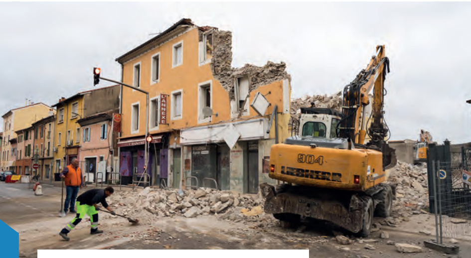
Rénovation en cours du faubourg du Soleil.
