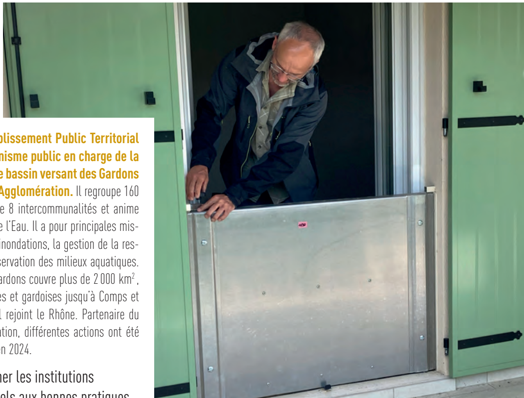
Installation d'un batardeau dans le cadre du dispositif Gardons ALABRI.
