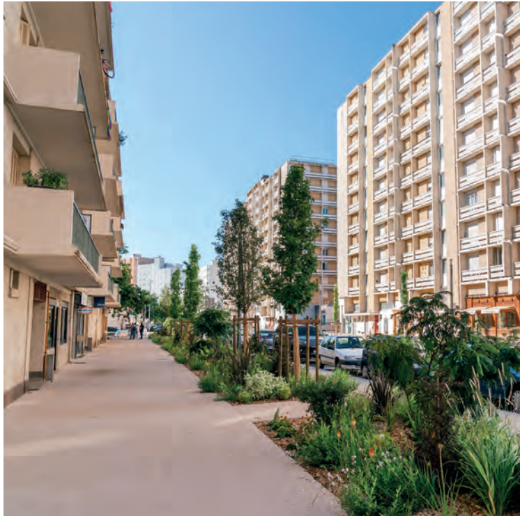
Le nouveau visage de la Grand'rue Jean Moulin commence à préciser avec ses trottoirs rénovés et ses nouvelles plantations. Les travaux s'achèveront fin 2025.
