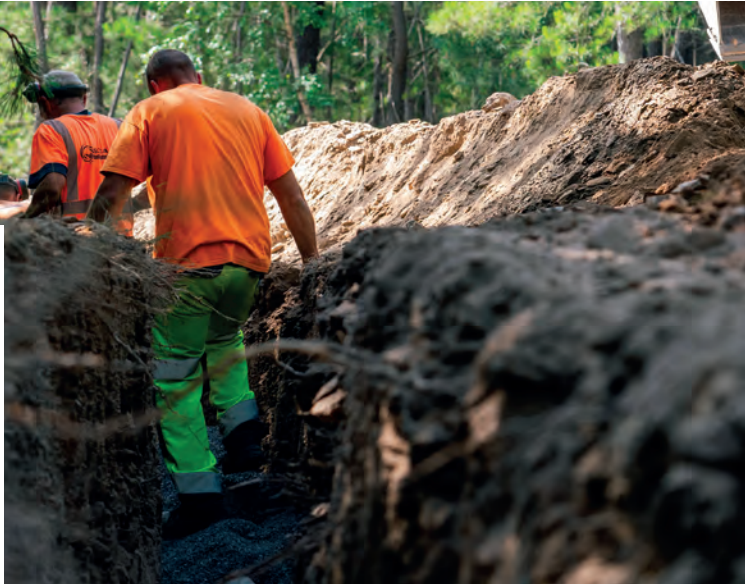
Le chantier a débuté à Sénéchas en juin, sur un terrain accidenté, pour raccorder dans un premier temps les deux réservoirs de la commune.
