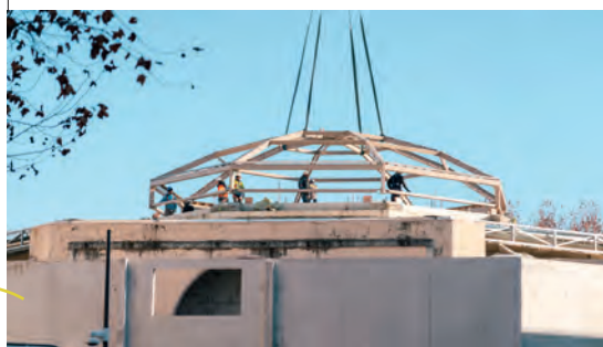
Installation de la nouvelle coupole le 12 décembre 2024.
