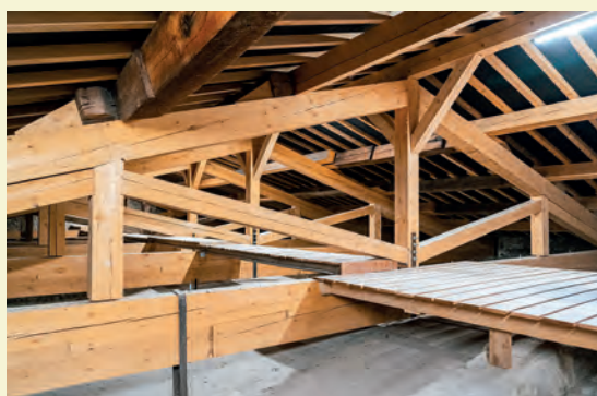
Une complète rénovation de la toiture pour ce bâtiment construit en 1823.
