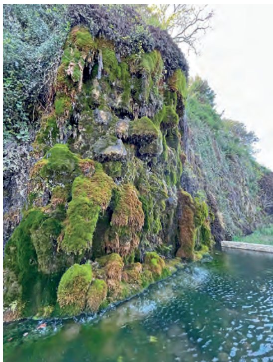
D'origine anthropique, le grand tuf de Maliver s'est développé sur la falaise artificielle construite à partir 1875 pour la voie ferroviaire entre Vézénobres et Quissac.
