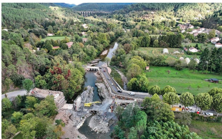
Les deux piles du futur pont des Châtaigniers ont pu être réalisées avant les fortes pluies automnales, condition essentielle pour envisager une mise en service avant l'été 2025.
