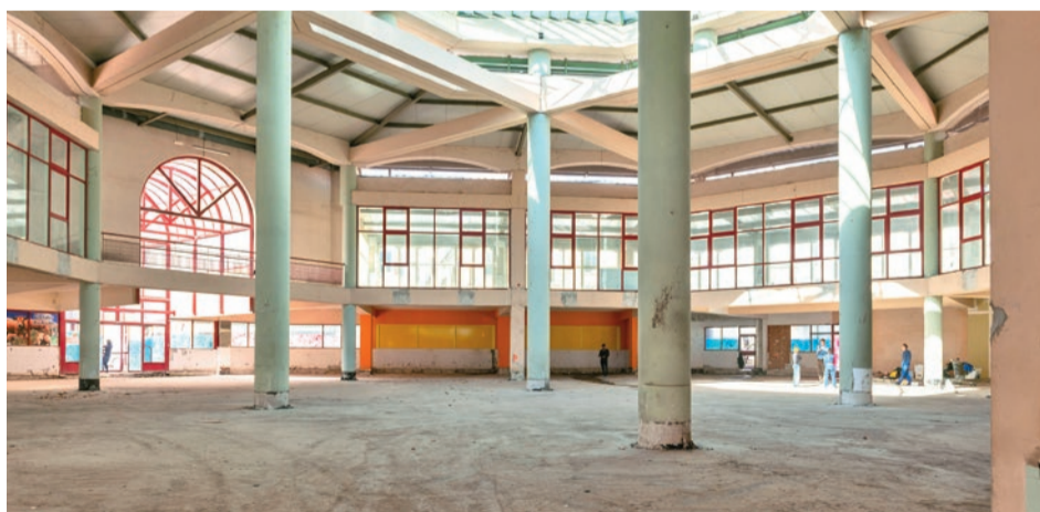
Après une première phase de "curage" fin 2023, les travaux d'aménagement sont lancés en avril avec deux petits mois de retard.
