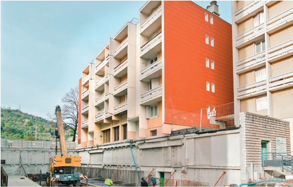
Les travaux de la "percée Cazot" doivent s'achever au mois de mars. S'ensuivra le début de l'opération de requalification de l'habitat social, dès le mois d'avril.
