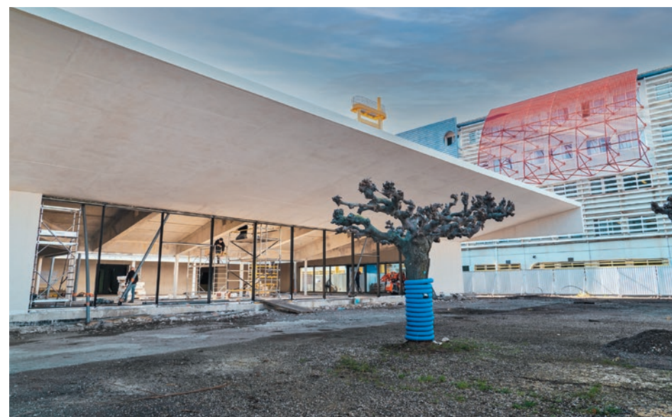
Les nouveaux bâtiments du lycée Jean-Baptiste Dumas seront prochainement équipés pour une livraison à la fin de l'année scolaire.
