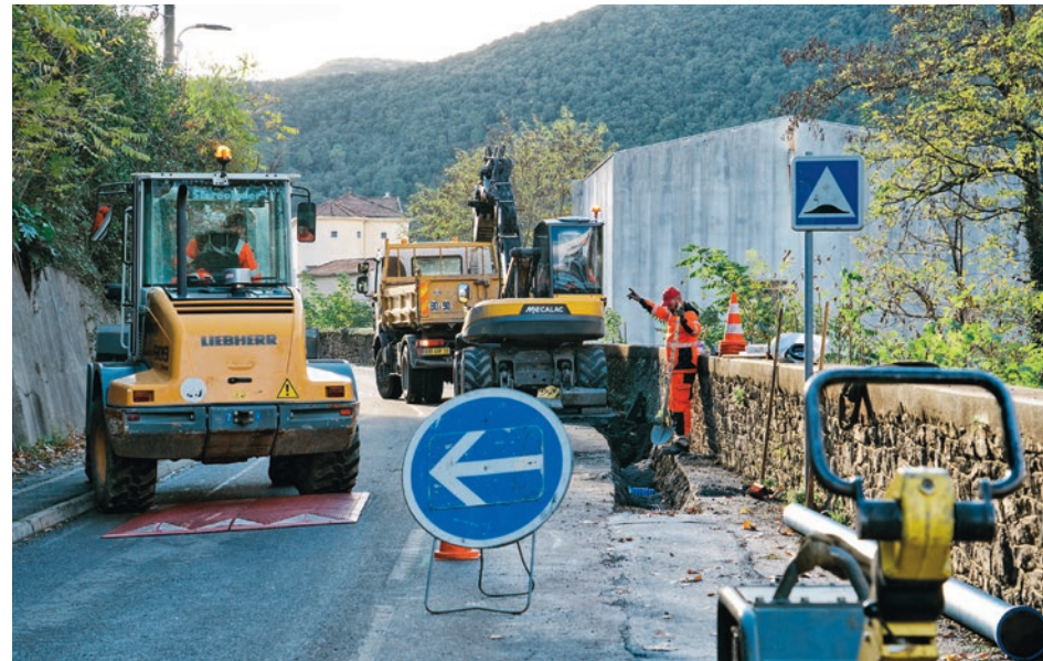
Débuté en zone peu habitée, le chantier s'achèvera en centre-ville de La Grand-Combe au printemps 2023.
