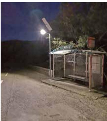
La société Solairgo a installé des lampadaires solaires au-dessus des abribus de Rouvière, Mazelet, Malérgues, La Montée, Elze et Massiès. L'efficacité a très vite été constatée : en fonction à 100 % deux heures avant le lever du soleil et trois heures après la tombée de la nuit, ils assurent ainsi une grande sécurité pour les enfants et les chauffeurs des bus scolaires.
