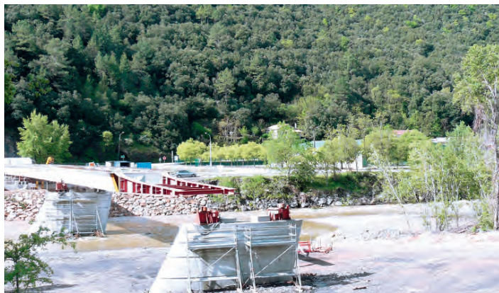
Les piles sont terminées. La structure du pont se met en place.
