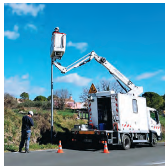
Les techniciens installent les nouvelles ampoules LED, moins gourmandes en énergie.
