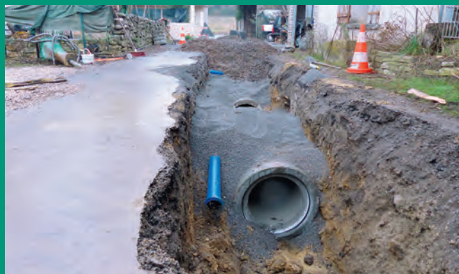
La tranchée a laissé apparaître la buse de 600 mm et la conduite d'eau potable.
