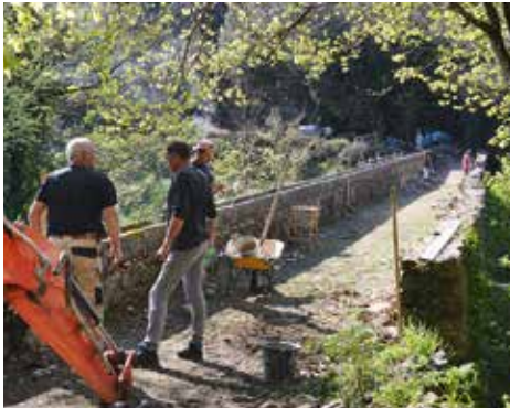
Le canal d'amenée d'eau réalisé en pierres de tailles a été démonté puis remonté.
