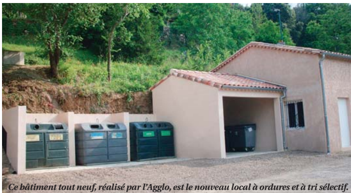
Ce bâtiment tout neuf, réalisé par l'Agglo, est le nouveau local à ordures et à tri sélectif.
