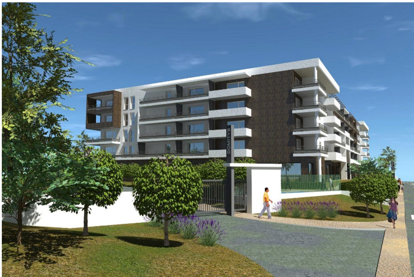
Construction d'une résidence seniors
