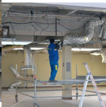
Le projet de modernisation nécessite le démontage complet
