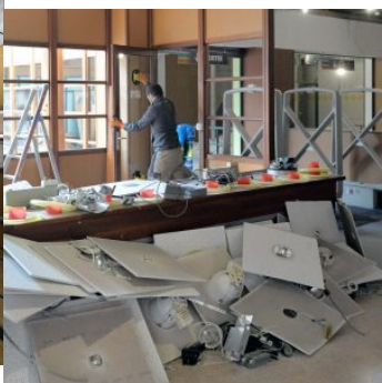
Le projet de modernisation nécessite le démontage complet de la médiathèque et
