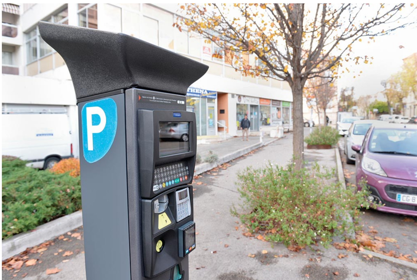
Mise en place des nouveaux horodateurs
