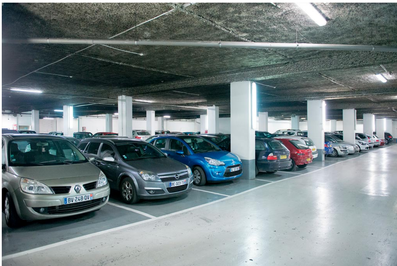
Rénovation des parkings souterrains
